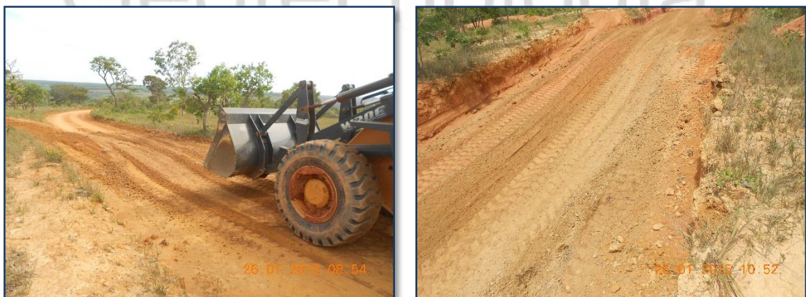
Figura 4: Cascalhamento de Lombadas.
