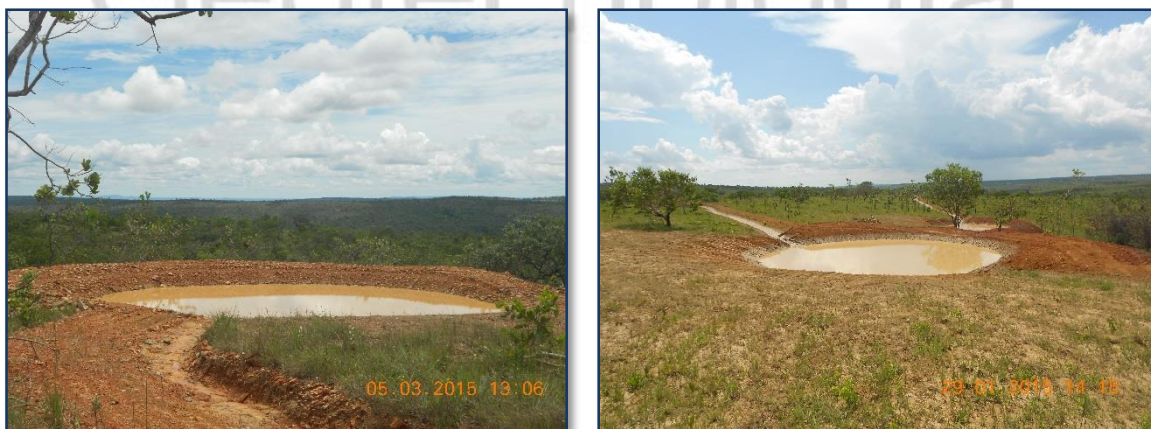
Figura 5: Bacias de contenção de águas pluviais (Barraginhas)
